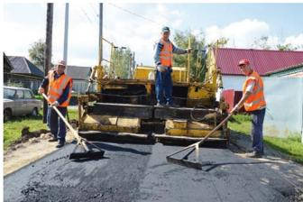
В Михайловку мы приехали, когда дорожные строители ООО «Босал» укладывали последние метры твердого покрытия на дороге по улице Нижняя. Всего же асфальт уложен на 600 мерах.
